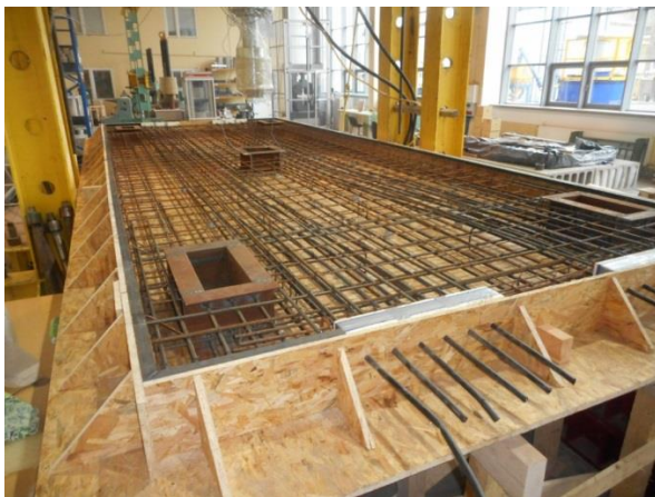
Rys. 6 Widok prototypu płyty wagi 30 tonowej przed i po zabetonowaniu.
