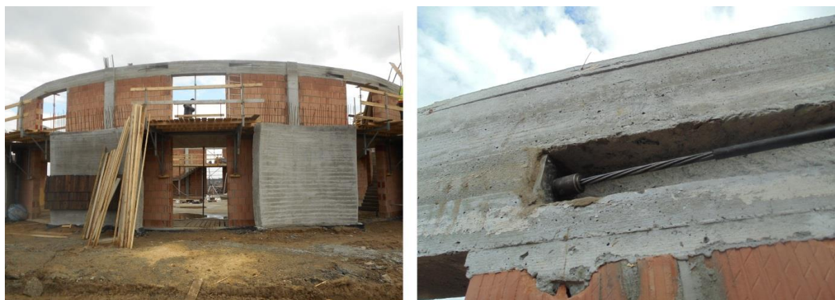
Rys. 16 Widok wieńca sprężonego i wnęki kotwiącej.
