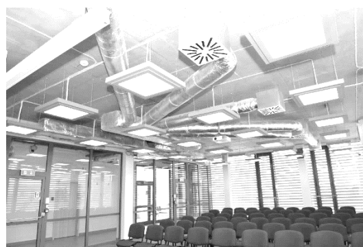
Pomieszczenie doświadczalne w budynku MLBE – intensywność wentylacji automatycznie dostosowuje się do liczby przebywających osób oraz oczekiwanej temperatury w pomieszczeniu
