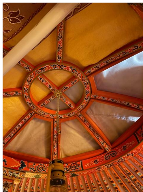
Fot. 4. Okrągły element wieńczący dach jurty, doświetlający oraz wentylujący wnętrze.
