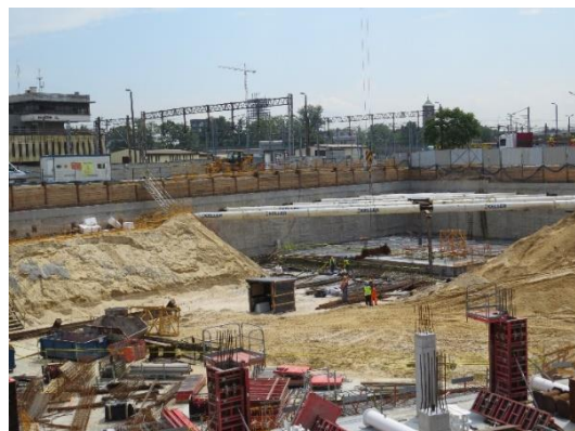
Ściana szczelinowa jako fundament biurowca high five w Krakowie
