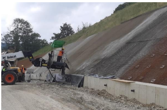
Zabezpieczenie skarpy drogowej na drodze S7 w Lubniu
