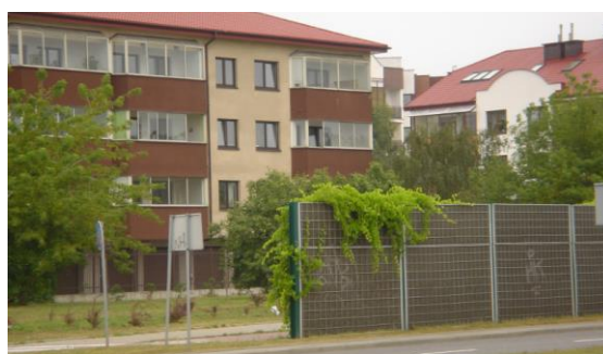
Rys. 15. Przenikanie fali akustycznej przez krawędzie boczne ekranu – rozwiązanie praktyczne
